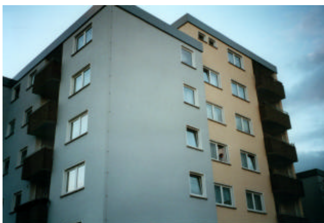
Abb. 9: Sanierte Schlichtbauwohnungen - Gießener Weststadt
